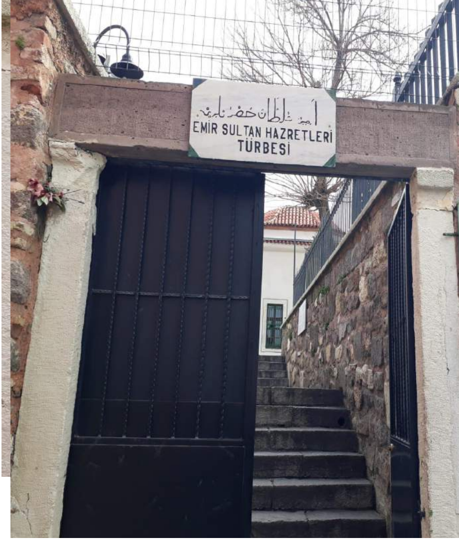
EK 10. Emir Sultan Hazretleri Türbesi Giriş Kapısı (Foto. Tuba Kocal).
